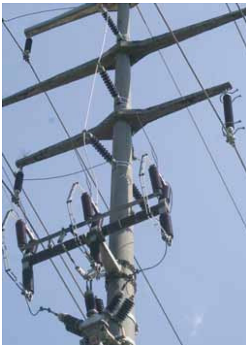
Abgang für die Elektra Ehrendingen von der Hochspannungsleitung Baden-Beznau
