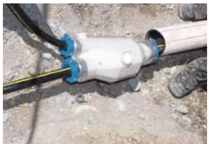
Erstellung einer Kabelabzweigmuffe
