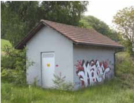
Transformatorenstation Chaltebrunne, Freienwil
