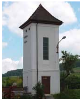
Transformatorenstation Dorf, Ehrendingen
