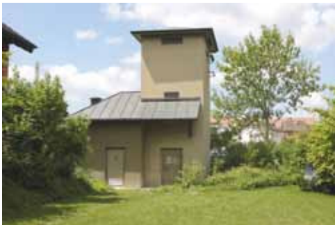
Transformatorstation Am Bach, Ehrendingen
