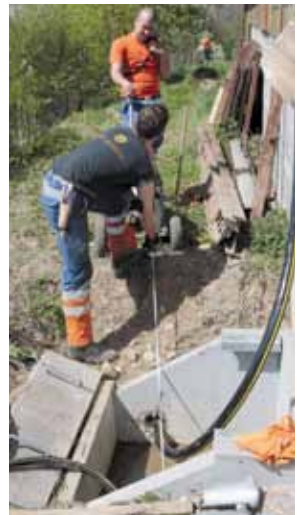
Kabelzug Klonhof, Ehrendingen
